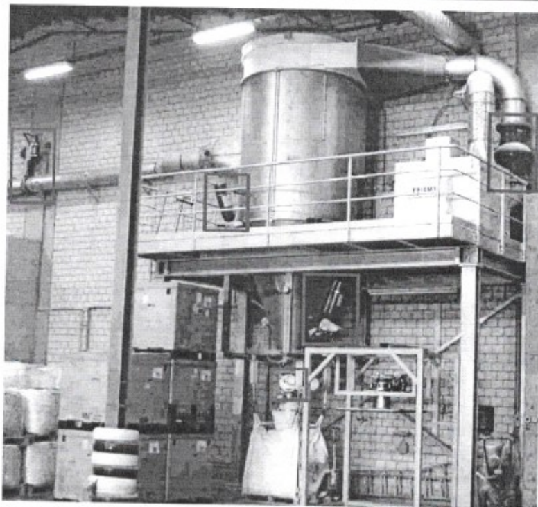
Esempio di Protezione Corretta: Filtro a Maniche – Soppressione dell'Esplosione con Isolamento
